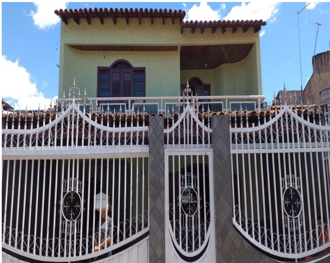
CASA DESCENTRALIZADA DA QNN 24 – CEILÂNDIA SUL
