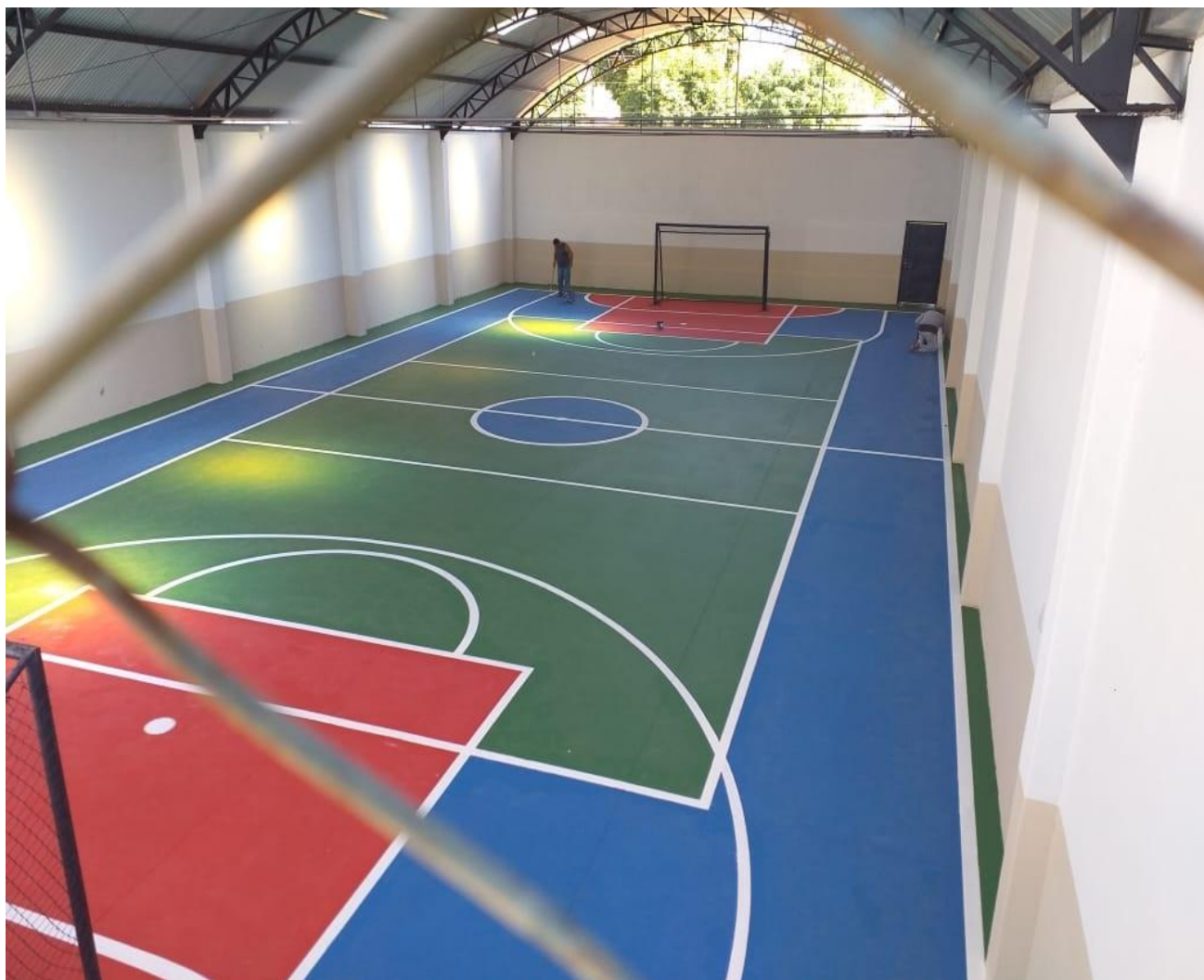
CONCLUSÃO DA REFORMA DA QUADRA POLIESPORTIVA – LAR DE SÃO JOSÉ
